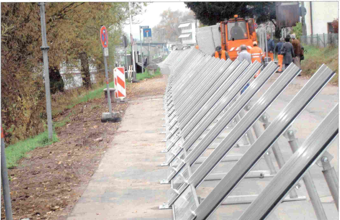
Mocowanie: koziół K-systemu przyśrubowany za pomocą kolka ziemnego do powierzchni ulicy
