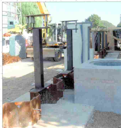
Montaż na ścianie szczelnej z adaptorem do odpowiedniej wysokości
