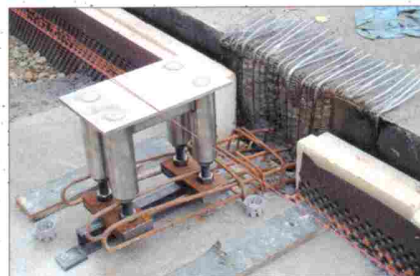
Montaż na gotowym (wykonanym) podłożu
