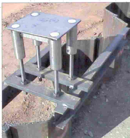
Montaż na ścianie szczelnej
