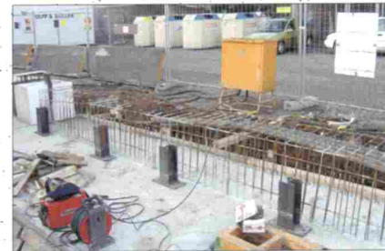
Montaż na gotowym podłożu z adaptorem do odpowiedniej wysokości
