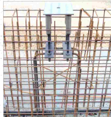
Montaż na strzemieniu ze stali zbrojeniowej
