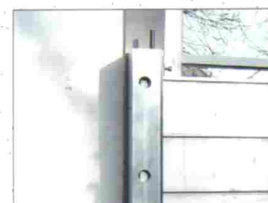
Montaż przed ościeżą
