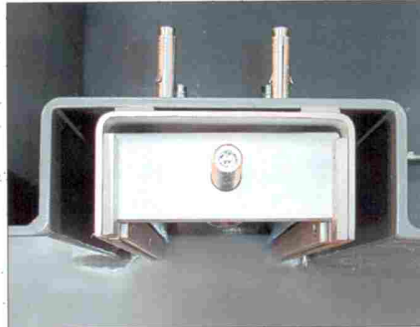
Montaż w przygotowanym gnieździe wewnątrz muru. Profile-słupy końcowe mocujące się na dyble. Następnie przednia strona zostaje zaszalowana i wypełniona zaprawą, która nie ulega kurczeniu się.
