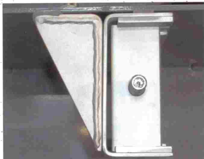
Montaż boczny za pomocą dybli, obciążenie tylko pod wpływem parcia wody na obiekt. Profile-słupy końcowe mocowane są bokiem do ściany obiektu przy pomocy kotwy rozporowej. Do mocowania można też użyć kotwy zespolonej.
