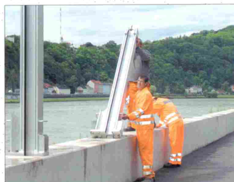
Słupy o wysokości 2,50m ustawiane są ręcznie
