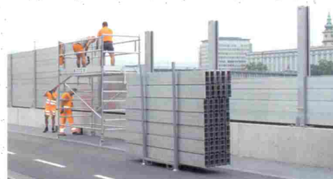
W dwóch etapach montuje się ścianę o wysokości 2,50 m przy pomocy jedynie dziesięciu belek zaporowych na każdym przęśle
