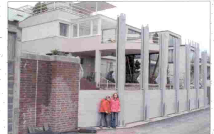
Słupy systemu mobilnego o wysokości 4,20 metra
