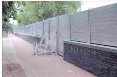
Obszar przejazdu z Hohenversprung
