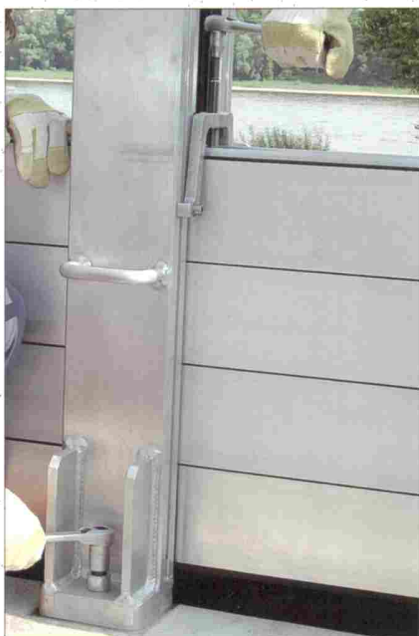
Przykręcanie stopy słupa i klucza do kompresji
