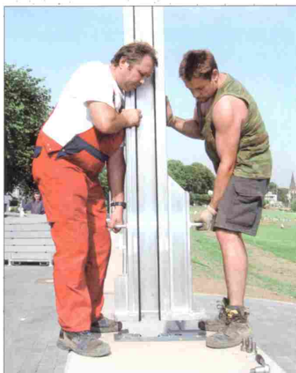
Dwóch mężczyzn niesie słup pośredni o wysokości 2,10 m
