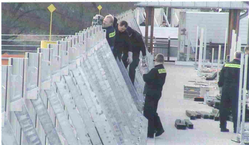
Montaż systemu firmy IBS przez THW.
