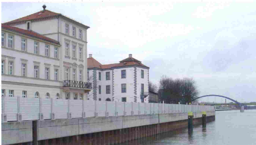
Podczas gdy Mobilny System Ochrony Przeciwpowodziowej jest zmontowany to mieszkańcy ze spokojem obserwują podnoszenie się poziomu wody na wodowskazie.
