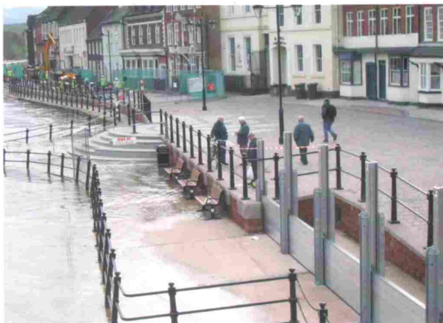
Montaż systemu w pełnej wysokości zabezpieczenia przeciwpowodziowego
